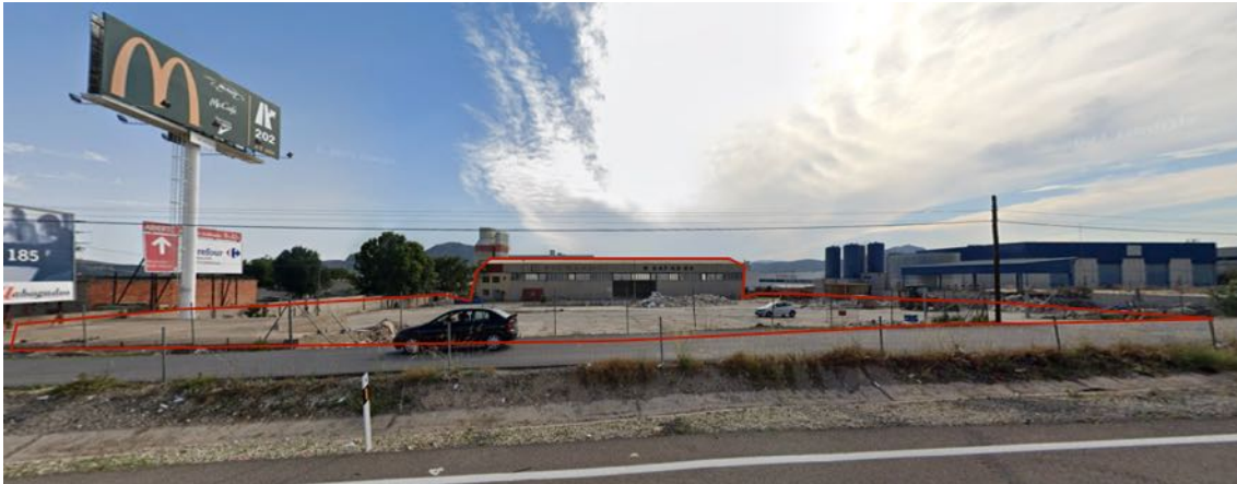
Fotografía 1. Vista frontal de la nave industrial.
